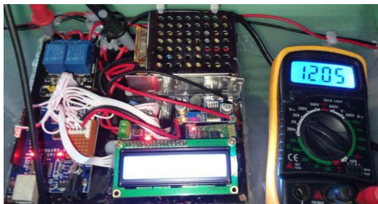
Gambar 6. Pengukuran Tegangan pada Relay Channel 1
